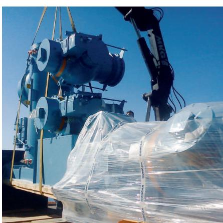
Isporuka GIS postrojenja 110 kV u transportnim jedinicama započela je od 2. travnja 2012. i sukcesivno se odvijala po gotovosti proizvodnje postrojenja. Elektromontažni radovi i sva ispitivanja na mjestu ugradnje izvršena su do 24. svibnja 2013. Tijekom elektromontažnih radova u TS Plat položeno je 36.932 m napajačkih i signalno - upravljačkih kabela te je postavljeno više od 1.146 m kabelskih polica i kanala.
