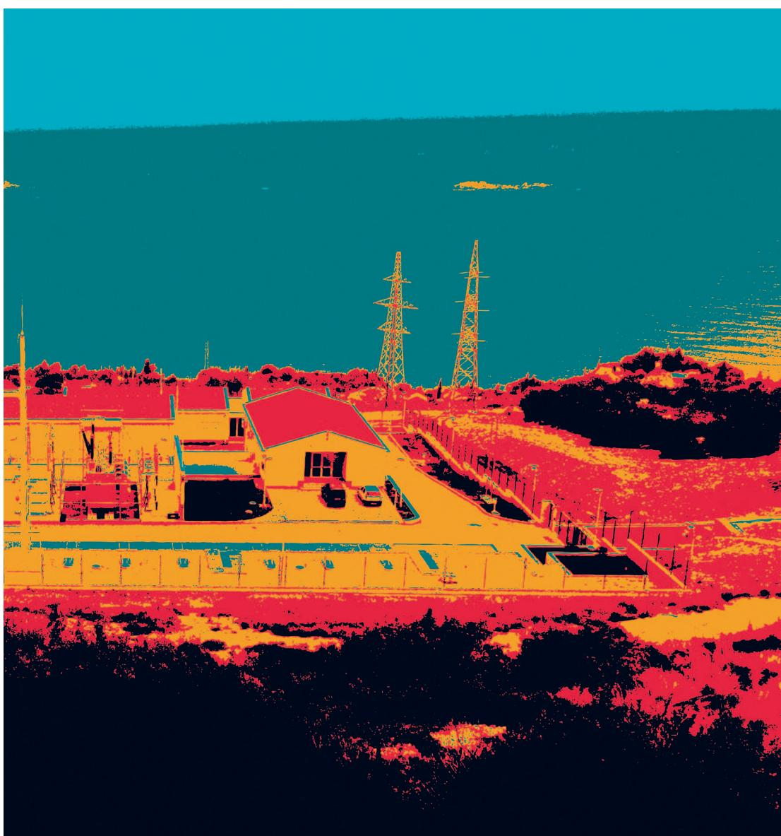
Radovi na izgradnji TS 220/110/35/20(10) kV Plat i priključnih vodova započeli su 22. listopada 2010. Sami zahvat u građevinskom dijelu karakterističan je po zahtjevnim zemljanim radovima u području potencijalno sklonom klizištima. Prvi beton u objekt TS ugrađen je 14. siječnja 2011. Ukupno je samo na trafostanici izvedeno 57.000 m<sup>3</sup> iskopa i ugrađeno 6.839 m<sup>3</sup> betona.
