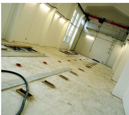
Elektromontažni radovi u TS Plat započeli su 15. veljače 2011. polaganjem uzemljivača tijekom izvođenja građevinskih radova. Prvi radovi na električnoj instalaciji i rasvjeti započeli su 10. siječnja 2012. u prostoriji za smještaj GIS postrojenja unutar zgrade postrojenja 220 i 110 kV. U prostoriji je ugrađena jedna mosna dizalica nosivosti 5t.
