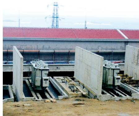
Dva autotransformatora 220/110 kV, 150 MVA dopremljena su 20. lipnja 2012. u TS Plat. Elektromontažni radovi i ispitivanja transformatora na mjestu ugradnje obavljena su do 8. prosinca 2012.
