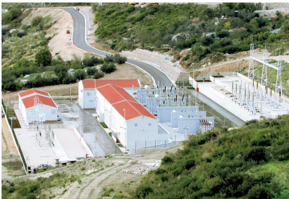
smještena je transformacija 220/110/35/20(10) kV koju čine dva autotransformatora 220/110 kV, 150 MVA (AT1 i AT2), transformatori 110/35 kV, 20 MVA (TR1) i 110/20(10) kV, 20 MVA (TR2) te međutransformator 35/20(10) kV, 16 MVA (MT). Transformatori za kućnu potrošnju 35/0.4 kV, 630 kVA (KT1) i 20(10)/0.4 kV, 630 kVA (KT2) nalaze se unutar prizemnog dijela zgrade upravljanja i nadzora.
